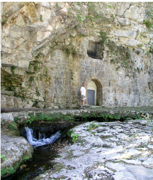
Illustration 61 – Mur de protection des Sourcets, Vence, Alpes-Maritimes.
